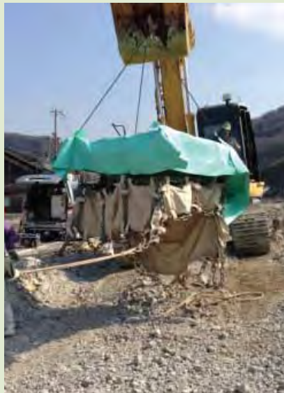
▲吊り込み状況
