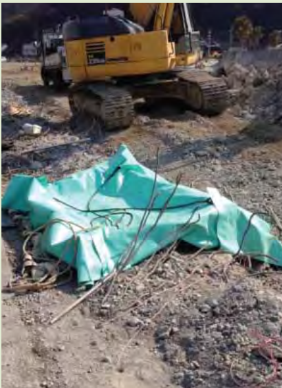
▲飛石・防音養生
