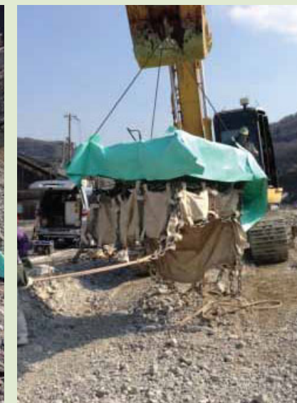
▲吊り込み状況
