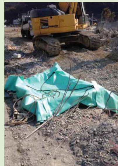
▲飛石・防音養生
